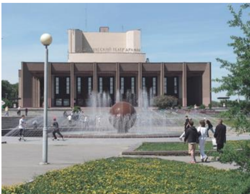
Рис. 2. Здание театра драмы XXI в. (до реконструкции)
