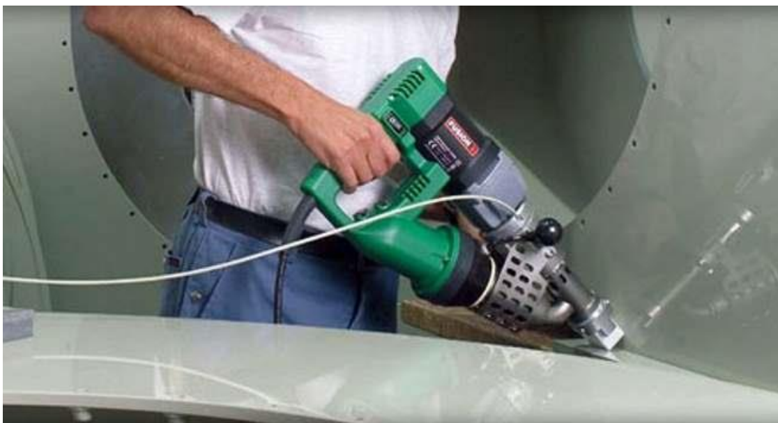
Рисунок 3 - Сварка полипропилена экструдером
